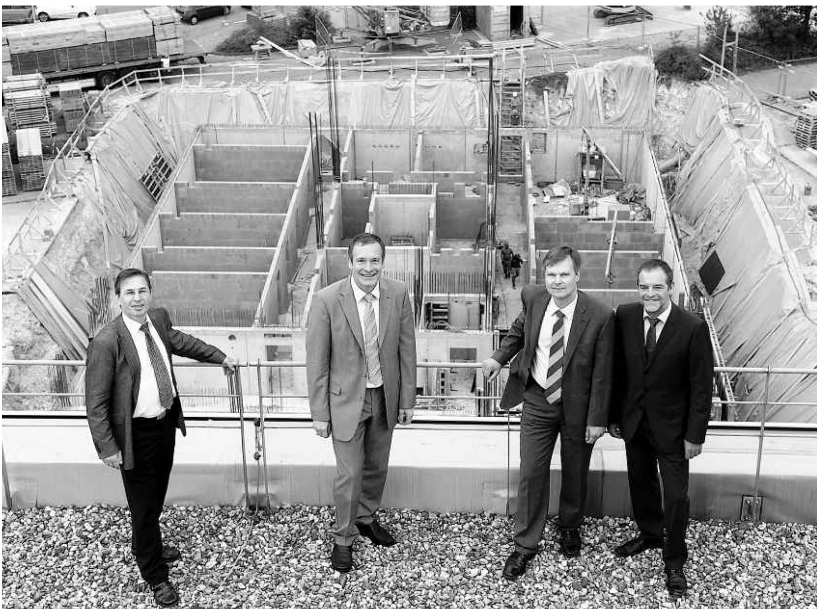
Erfreut über die Fortschritte in der Baugrube: Dr. Helmut Greif, Professor Thomas Schmitz-Rode, Dr. Ralph Nussbaum und Harald Mohren (von links) vor den ersten Gebäudeteilen des neuen Zentrums für Bio-Medizintechnik, das derzeit an der Pauwelsstraße unweit des Universitätsklinikums aus dem Boden gestampft wird.
